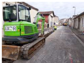
Renouvellement réseau eau potable Rue Gambetta Macau
