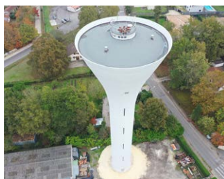
Château d'eau du Pian-Médoc
